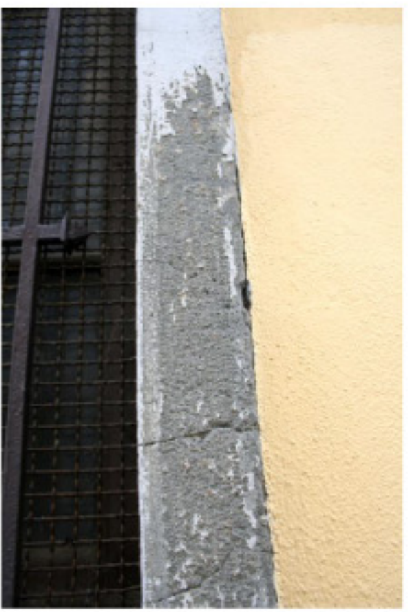
Particolari cornici e davanzali delle finestre realizzati in cemento lavorato a pié d'opera. Le fasce dei montanti verticali sono martellinate. La lavorazione attualmente non è più visibile in quanto ricoperta da più strati di tinteggiature e i serramenti sono in legno con grate in metallo.
