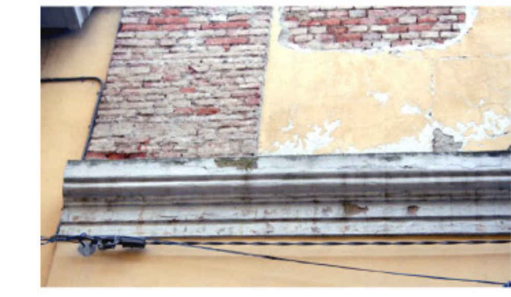
Particolare delle lesene orizzontali realizzate con mattoni e modellate in opera con malta di cemento, ricoperta d'innumerabili strati di pitture successive.
