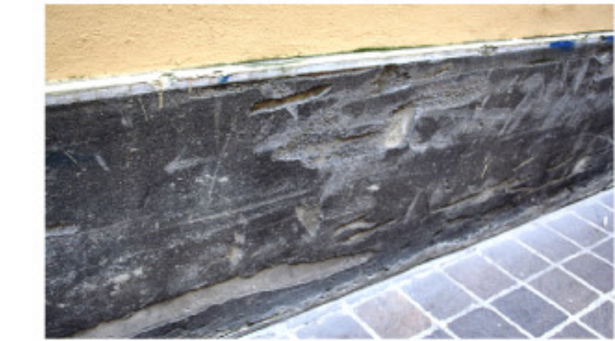
Particolare della zoccolatura realizzata con malta di cemento, ricoperta con intonachino plastico tipo "terranova".
