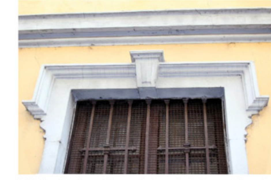
Particolare delle decorazioni sopra finestra, realizzate in cemento lavorato a pié d'opera. Anche in questo caso, gli strati di tinteggiature e le stuccature successive, rendono difficile la lettura della lavorazione delle superfici.
