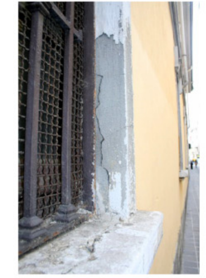
Particolari cornici e davanzali delle finestre realizzati in cemento lavorato a pié d'opera. Le fasce dei montanti verticali sono martellinate. La lavorazione attualmente non è più visibile in quanto ricoperta da più strati di tinteggiature e i serramenti sono in legno con grate in metallo.
