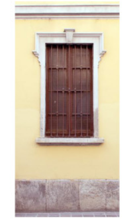
Particolare finestra e zoccolatura in lastre di pietra naturale (beola)
