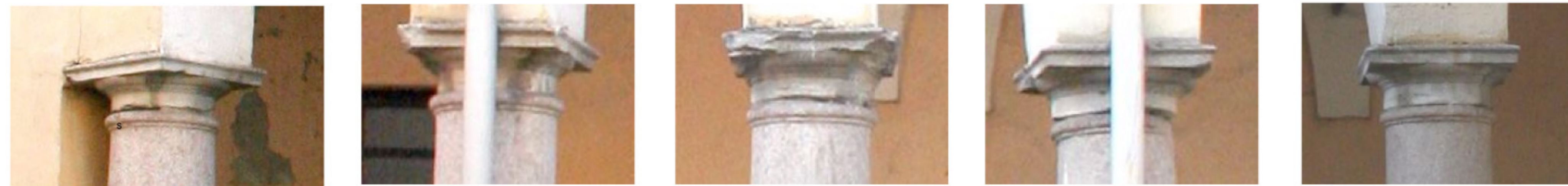
Particolari dei capitelli delle colonne realizzate in granito bianco.
