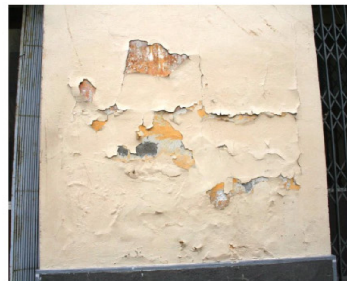
Particolare dell'intonaco cementizio realizzato in più strati con finte giugate successive.
