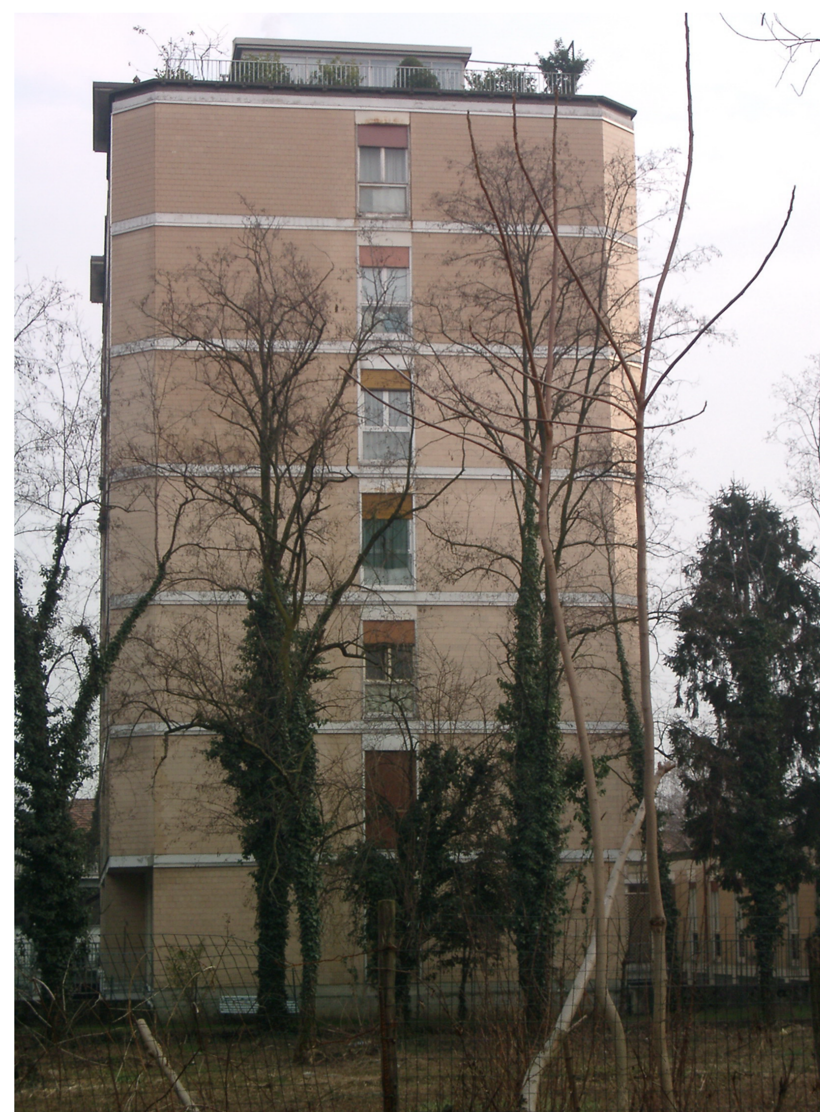
FACCIATA NORD - EDIFICIO VIA MELETTE DI GALIO
